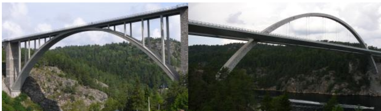
Abbildung 1: Alte Svinesundbrücke (Schweden) 1
